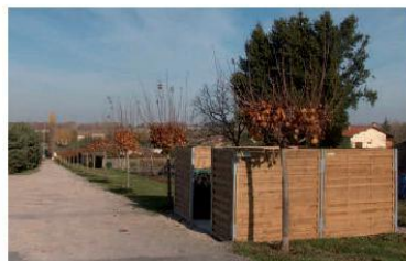
Point d'apport volontaire bien intégré à l'aménagement - Structure bois plus discrète.
