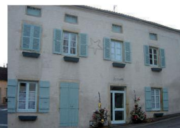
Bâtiment communal réhabilité en logements locatifs aidés, Melay (71) Maîtrise d'ouvrage communale
