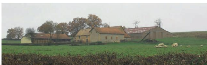
Exemple de bâtiment agricole dans le paysage du Charolais Brionnais
