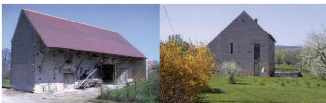
Réhabilitation d'une grange dans la vallée de la Grosne (avant/après) réalisation Lambert SARL, dessin des ouvertures de Mr Raynaud architecte
