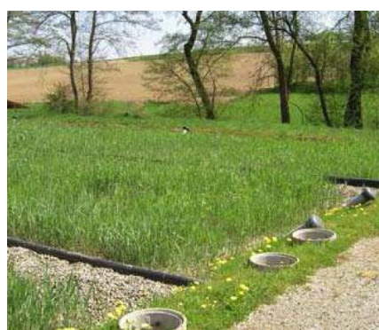
Station d'épuration en filtres à roseaux à écoulement vertical source : Agence de l'eau Rhin Meuse
