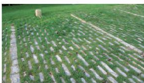
Stationnements pierres enherbées drainant.
