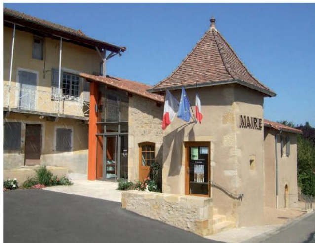
Réhabilitation de la mairie de Saint Bonnet de Cray (71) Keops Architecture (Mr Boucaud, Mr Vizier)
