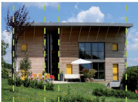
Façade contemporaine réinterprétant des ouvertures typiques des bâtiments du Charolais Brionnais. Exemple de la baie vitrée rappelant les ouvertures de granges mais jouant un rôle énergétique de jardin d'hiver. Maison individuelle privé (Mancey, 71), Pierre et Karine Rattiez arch.
