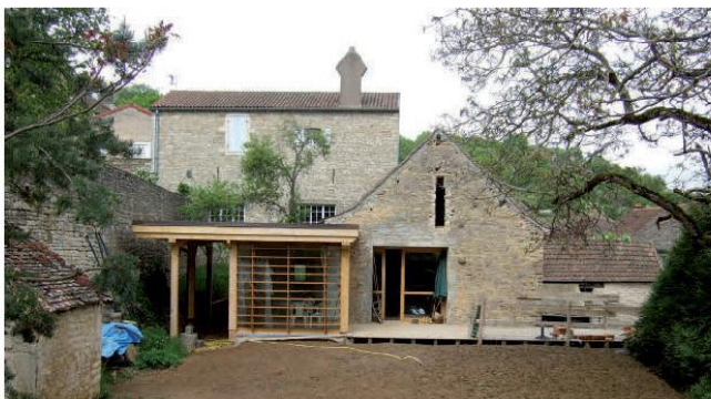
Réhabilitation d'une Grange en maison d'habitation (71), extension du volume principal en bois, Philippe Vieuxmaire architecte
