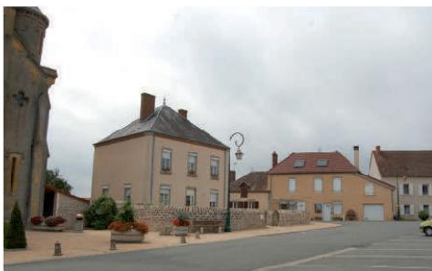
Rénovation de façade avec des couleurs plus sobres, nous pouvons regretter la pose de volets et de caissons apparents en PVC qui appauvrissent la façade historique Milly sur Arroux (71)
